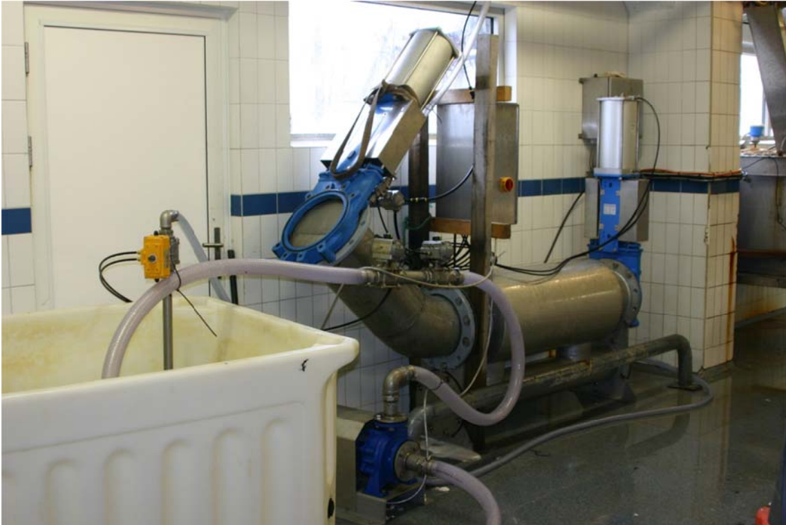
Figur 7. Testanlegg Vakuumtank og kar for sirkulering av lake.
